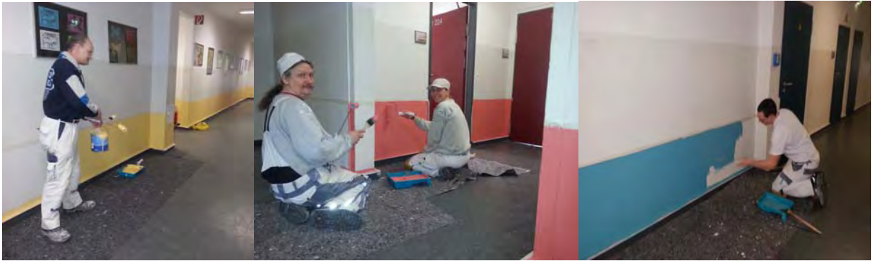
Abb. Aufbringen der Farbstreifen in den 3 Hauptfluren Februar 2013 durch die Malerfirma TAVERPACK
